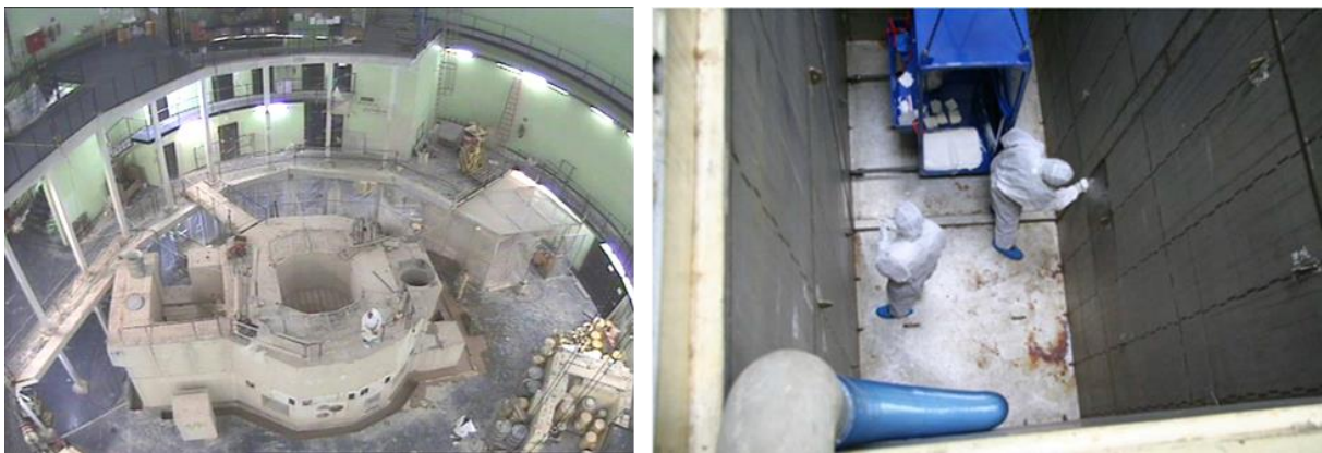
Abbildung 2: Rückbau des Forschungsreaktors ASTRA und Brennelementlagerbecken in Seibersdorf
